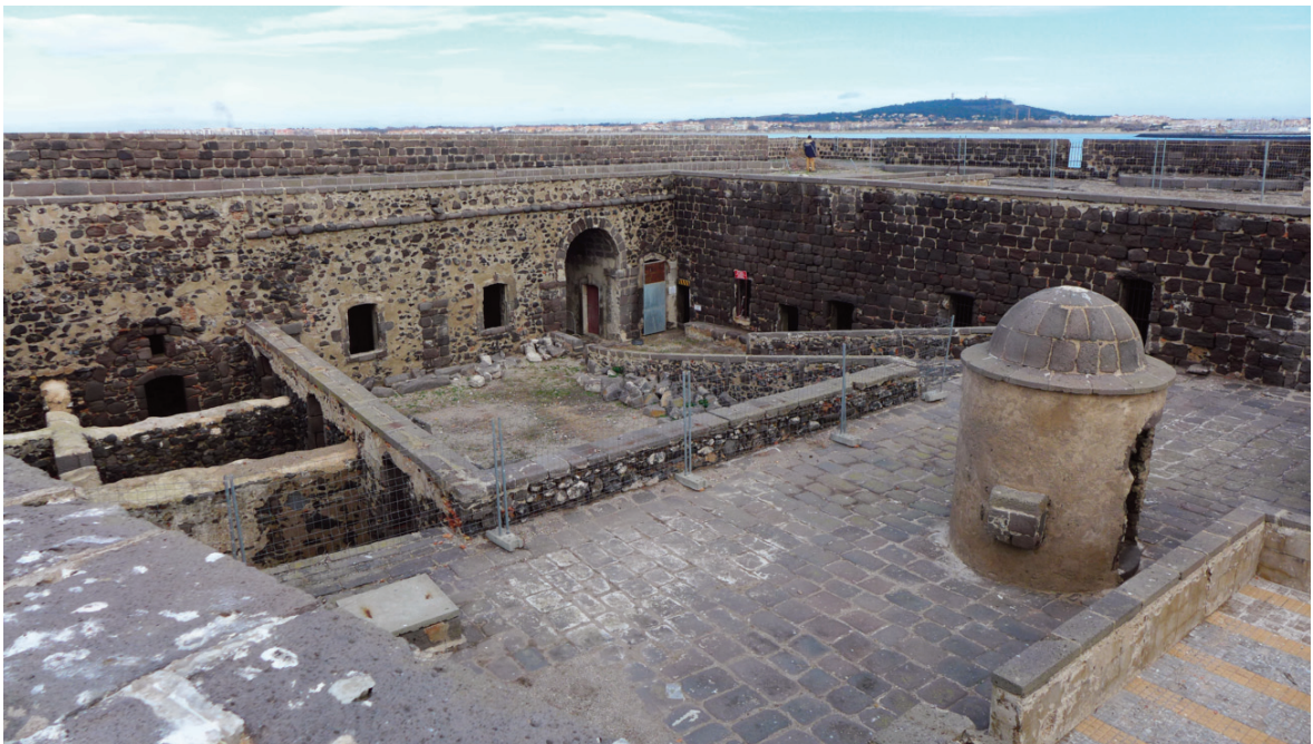
L'intérieur du fort aujourd'hui avec l'état des destructions : à gauche, le premier étage des anciennes prisons, à droite l'ancien logement de l'aumônier et, en face à droite, le premier étage du grand bâtiment devenu terrasse (photo Alain Sagnes),
