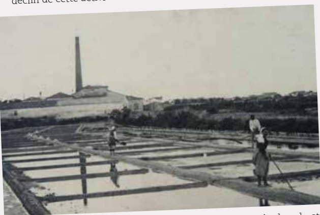
Alors que l'activité salicole bat son plein, une raffinerie de sel est construite près du port d'Ars en 1818. Elle est destinée à transformer le gros sel gris en sel fin de table. Elle cesse son activité en 1925. La cheminée est détruite en 1977. Avec elle disparaît l'un de ses derniers et rares symboles industriels de l'île de Ré.
