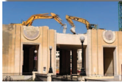
▲ Mai 2011, démolition de City Gate
