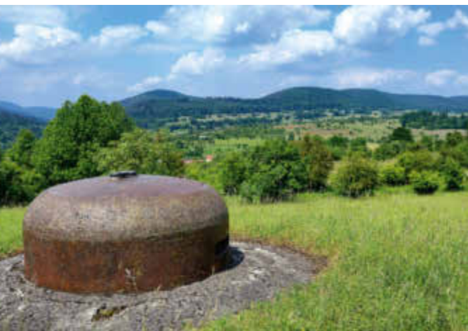
Cloche d'observation fixe avec périscope du bloc 4.
