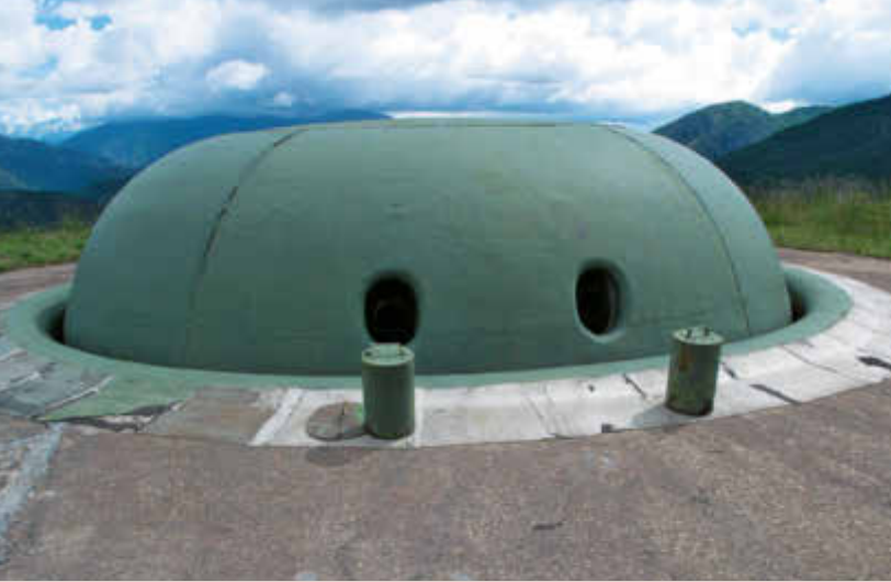
La fameuse tourelle Jeanne d'Arc de type Mougins de 155 mm pèse 200 tonnes.
