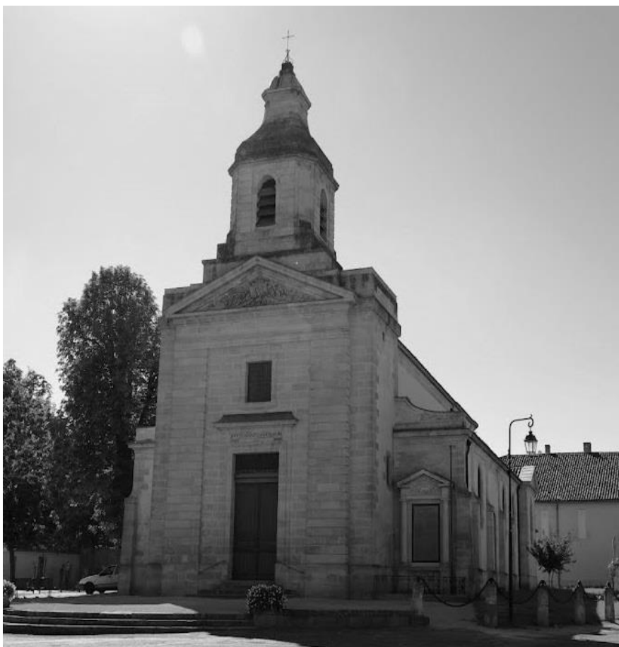
Église Saint Didier de Cantenac
