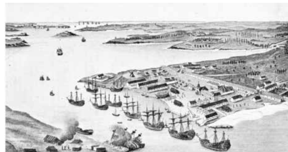
Le port de l'Orient en 1690. En bas, à gauche, la fumée indique qu'on est en train de préparer du brai ou du goudron pour calfater, ou recalfater, le vaisseau qui est à proximité, qu'on a abattu en carène pour faciliter le travail.
