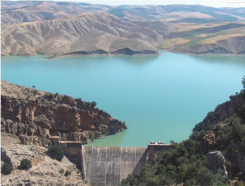
Situé sur l'Oued Beht dernier affluent important de l'oued Sebou avant son embouchure, à environ 20 km au Sud de Sidi Slimane, le barrage El Kansera réalisé entre 1927 et 1935 est le plus ancien barrage d'accumulation du Maroc. Cet ouvrage en béton de conception mixte, poids et contreforts, est fondé sur des terrains marnocalcaires à l'origine de grandes difficultés lors de la construction.
