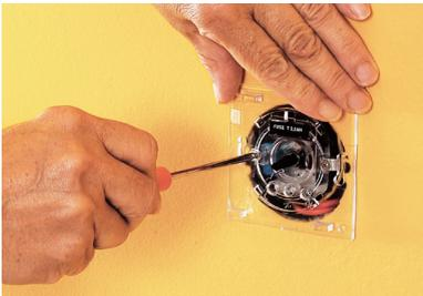
**5** Vissez le corps de l'interrupteur sur la boîte d'encastrement, à l'aide d'un petit tournevis cruciforme. Attention, la norme interdit désormais les boîtiers à griffes au profit du support à vis.
