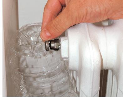
**2** Il existe différents modèles de purgeur d'air : à molette, à clé carrée, ou encore manœuvrables avec un tournevis. Leur rôle est le même : chasser l'air contenu dans les canalisations.
