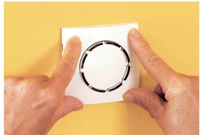
**6** Remplacez la molette centrale et son cache, puis clipsez la plaque frontale d'une simple pression des pouces. Remettez sous tension et contrôlez le bon fonctionnement de votre installation.
