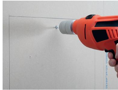
**4** Percez avec une mèche adaptée au support (diamètre indiqué en principe sur l'emballage des chevilles, ici 8 mm).
