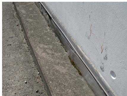
*La dalle en béton vient protéger le relevé d'étanchéité, le dissimulant en partie. Rien ne s'y oppose. Mais la réparation du relevé d'étanchéité conduira à démolir la dalle. Soigner l'exécution s'impose.*
