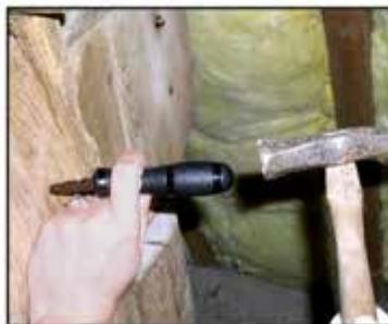
2 Introduisez les chevilles d'injection dans les perçements, puis enfoncez-les à l'aide d'une bouterolle en nylon et d'un marteau ou d'un maillet.
