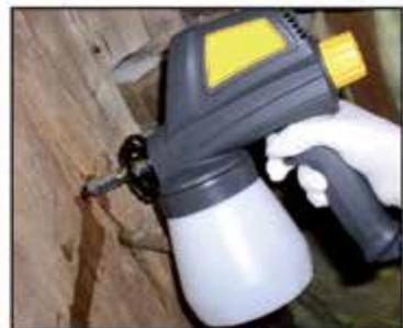
3 Injectez le produit à l'aide d'un pistolet à pression muni d'un embout adapté aux chevilles, à raison de 20 ml de produit par injecteur. Effectuez ensuite un traitement de surface en trois passes à la brosse ou au pulvérisateur.
