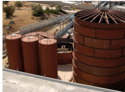
FIGURE 1.4. Couverture d'ouvrage en coque (à gauche) et silo (à droite) : tous deux sont des éléments de coque (éléments 2D gauches). © DR et Pierre Engel.
