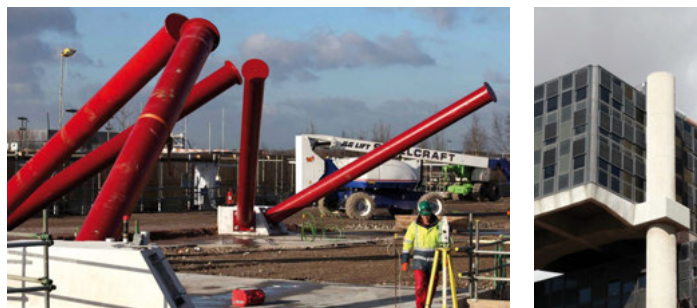
FIGURE 1.3. Les massifs de fondation des jambages métalliques (à gauche) et un nœud massif de jonction de poutres (à droite) sont des pièces compactes (éléments 3D). © Pierre Engel
