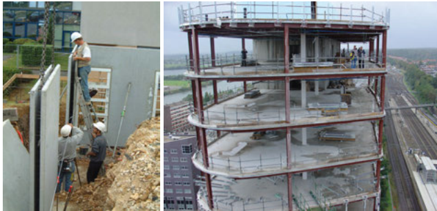
FIGURE 1.5. Les pré-voiles jumeaux préfabriqués (à gauche) et les planchers en béton d'un immeuble en construction (à droite) constituent des « plaques » au sens de la mécanique du solide. Ce sont des éléments de structure bidimensionnels et plans. © Pierre Engel.
