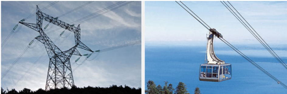
FIGURE 1.7. Les câbles à haute tension (à gauche) doivent supporter leur poids propre et, le cas échéant, une charge de glace. Il en est de même pour les câbles des téléphériques (à droite) ou encore des câbles qui supportent le filet de l'Arche de la Défense à Paris, par exemple. Ce sont des éléments longiformes courbes dont la forme s'accommode – on dit « funiculairement » – du système de charge (éléments 1D courbes). © Shutterstock / Ingrid Petitjean.
