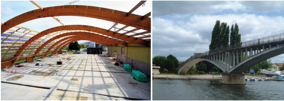
FIGURE 1.6. Les arcs en bois (à gauche) ou en béton (à droite) constituent des éléments de structure longiformes courbes (éléments 1D courbes). © Pierre Engel.
