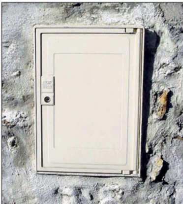
Figure 2 : Exemple de coffret de raccordement au réseau
