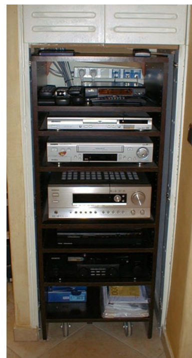
Figure 2.29 Meuble de rangement hi-fi sur roulettes facilitant la maintenance de l'installation (source Cust Home)
