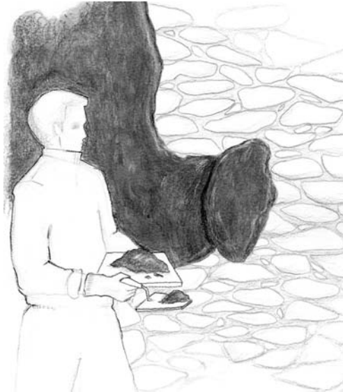
1. Projection du gobetis sur le mur arrosé.
