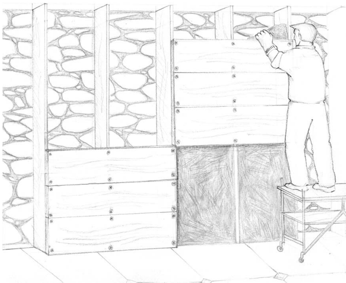
Mise en œuvre d'un enduit terre-paille dans des banches
