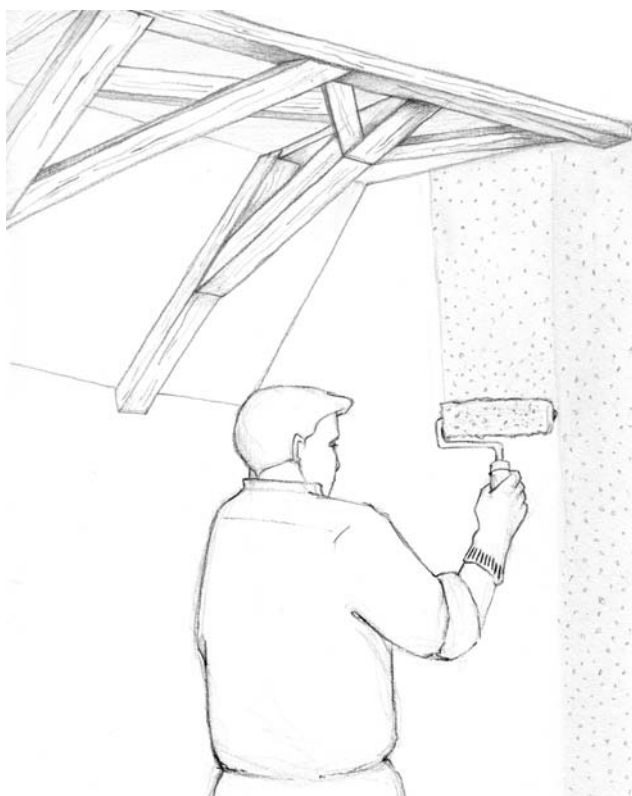
Application de colle à papier peint additionnée de sable sur un support lisse
