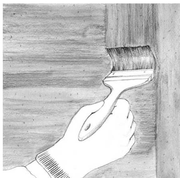
2. Poursuite de la mise en œuvre par bandes verticales.
