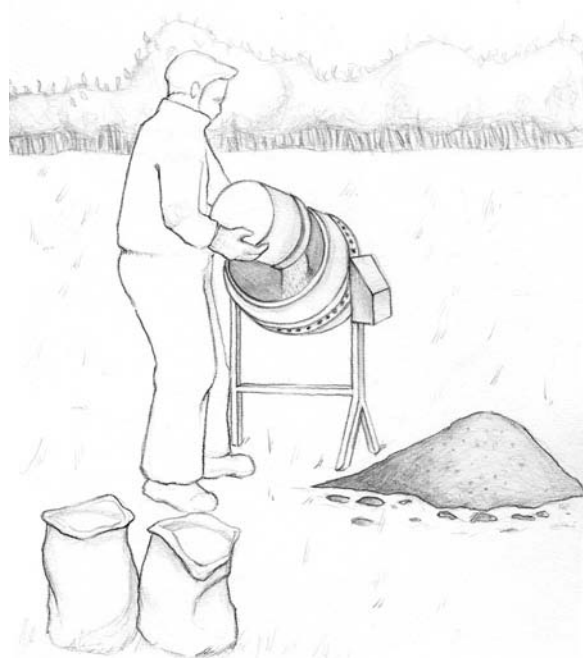
2. Incorporation du volume de liant fait de chaux aérienne et de chaux hydraulique naturelle.
