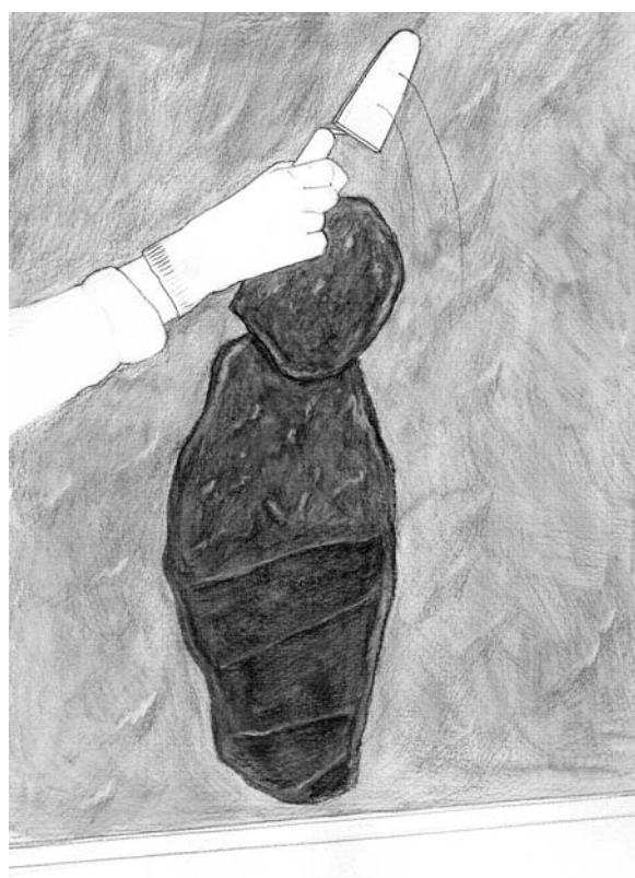
2. Projection des truellées à partir du soubassement.
