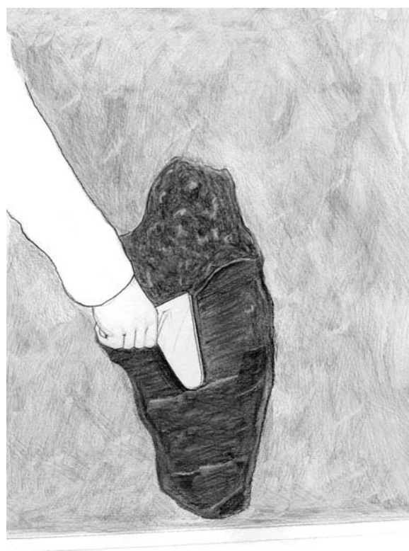
3. Lissage du corps d'enduit au dos de la truelle.
