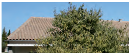
Présence d'un arbre pouvant faire de l'ombre à l'installation photovoltaïque.
