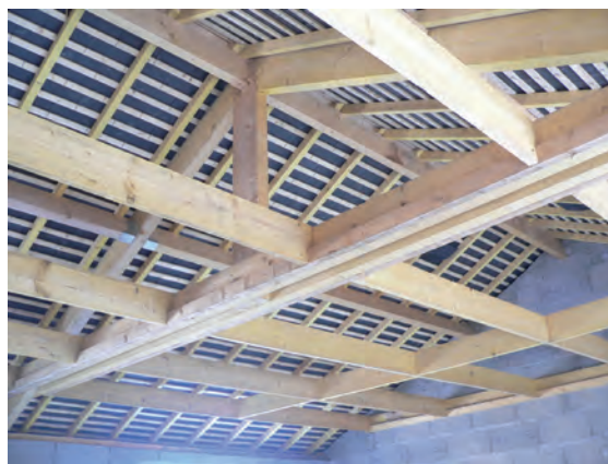
Charpente en bon état. © Nicolas Février - Fotolia.com
