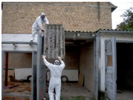
Opération de désamiantage.
