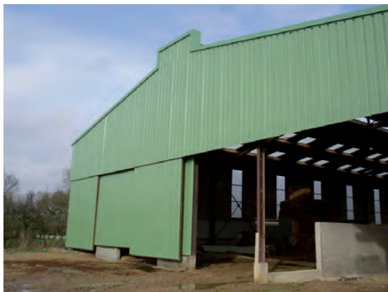
Pour ce bâtiment, il est pertinent de faire établir une étude de la charpente par un bureau d'études structure.
