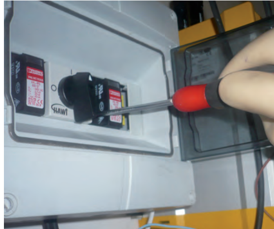
Intervention sur un coffret électrique.
