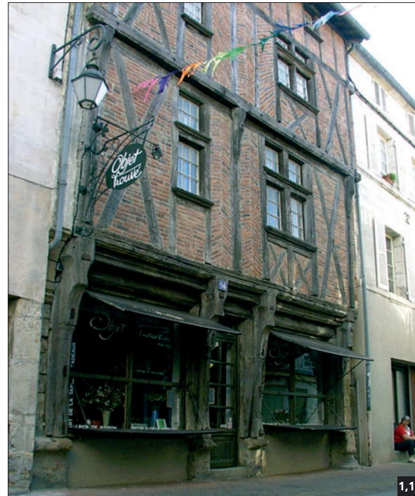
Fig. 1,12 L'encorbellement prend appui sur la sablière d'étage qui repose sur les solives.
