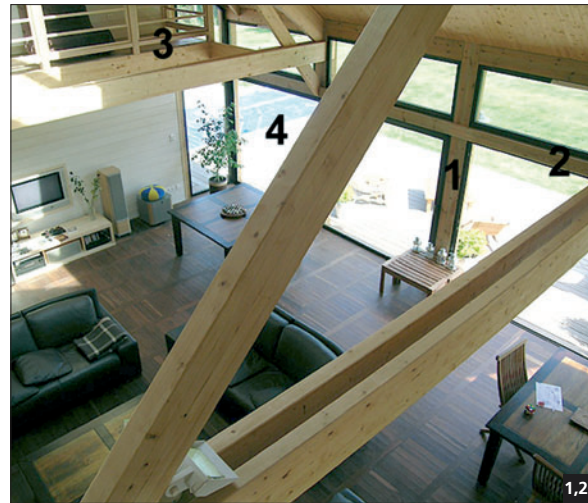
Fig. 1,26 Ce bâtiment a une ossature avec une trame espacée de 3 m.
