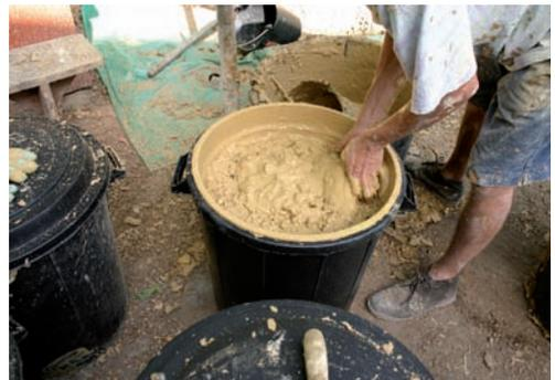
On malaxe la terre de façon à bien séparer les cailloux de la terre. On peut récupérer les cailloux encore bien enrobés de terre et les repasser à la bétonnière pour obtenir un lait de terre à utiliser pour un gobetis, par exemple.
